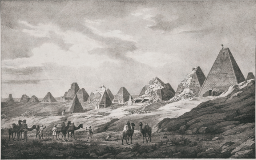
VUE GÉNÉRALE DES PYRAMIDES À UNE LIEUE DU NIL, PRISÉ DU NORD-EST.
